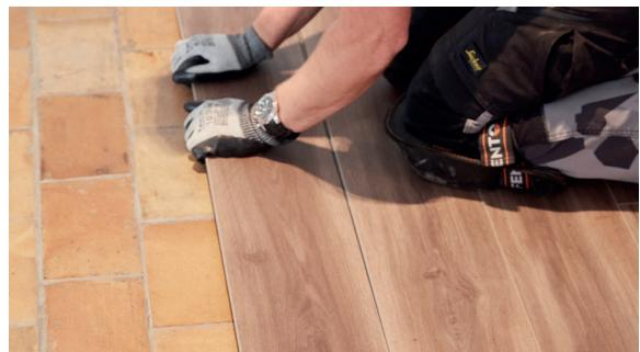
Для укладки последнего ряда панели приходится сужать. Это делается следующим образом: положите панель поверх предыдущего ряда пазом к стене, положите еще одну панель лицевой стороной вниз, прислонив ее к стене, и сделайте пометки на нижней панели. Разрежьте панели, сузив их до нужного размера, и уложите таким образом последний ряд.
